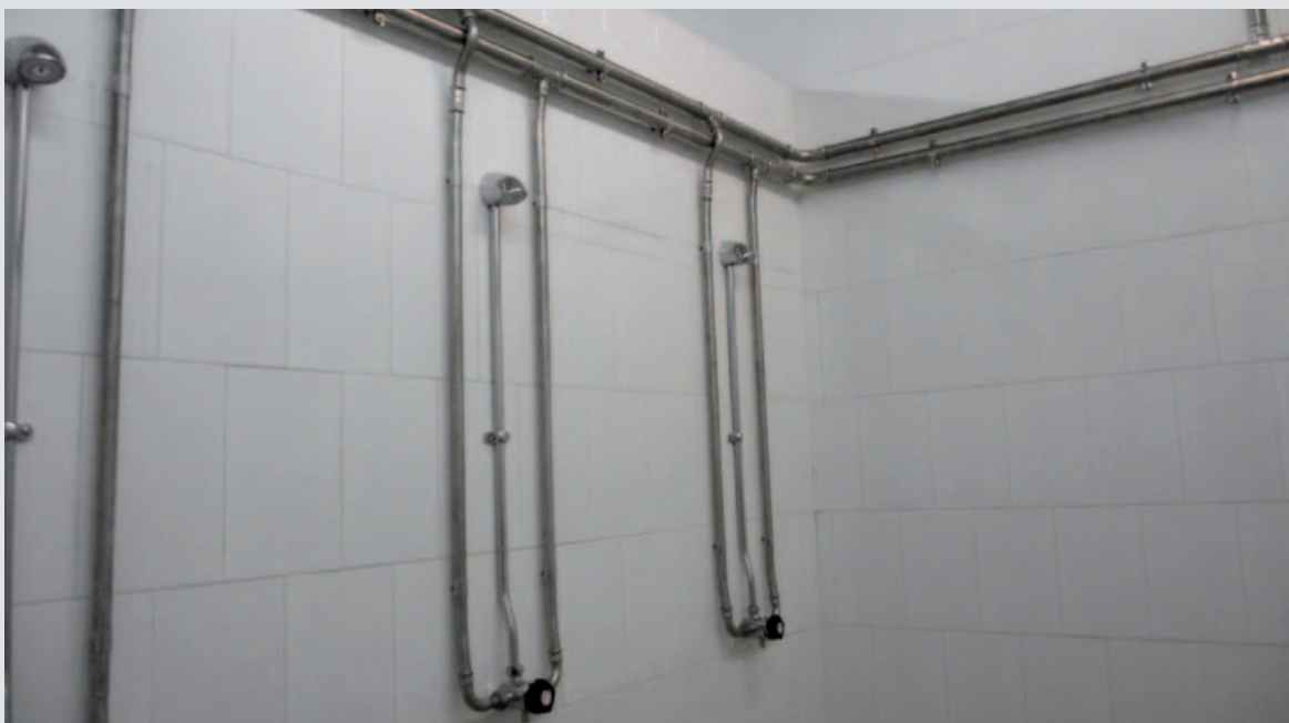
El pavelló de la Draga té les canalitzacions de les dutxes noves
